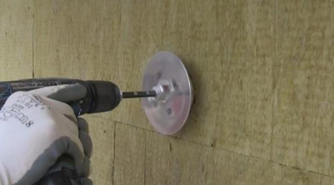
Knauf Insulation pokrivka za pričvršnice (rondela)
